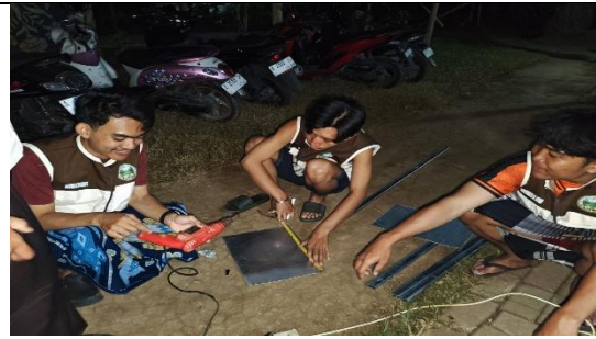
Melakukan penyambungan plat dengan tiang menggunakan bor
