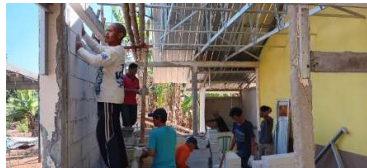
Gambar 5. Pembangunan Rumah Edukasi Konstruksi
