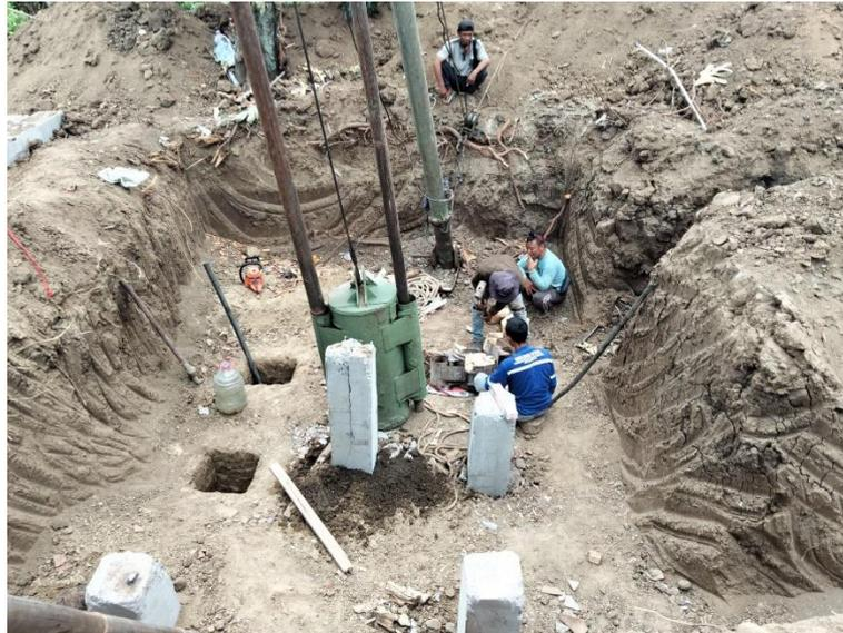
**Gambar 6. Pemancangan Pondasi Abutmen**
