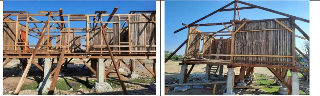
**Gambar 6. Pemasangan Dinding Bebak dan Rangka Atap Rumah Panggung**
