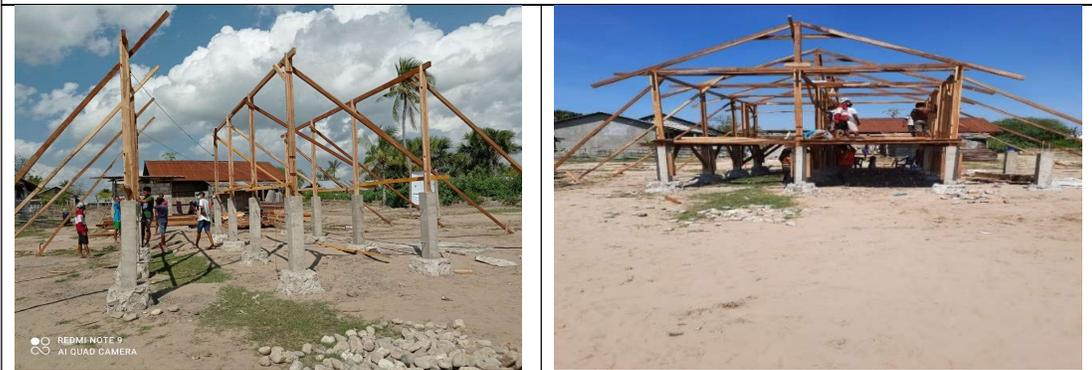
**Gambar 5. Pemasangan Tiang Kayu pada 12 Pilar Rumah Panggung**
